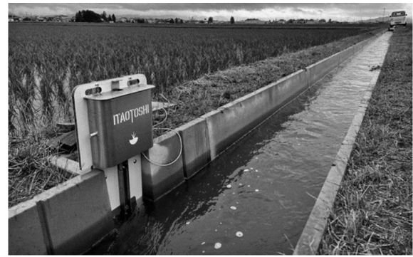
写真-2 フリーム給水部の堰板溝への設置
