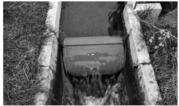
写真-4 ゲタ水ブロックによる効率的な水位堰上げ
